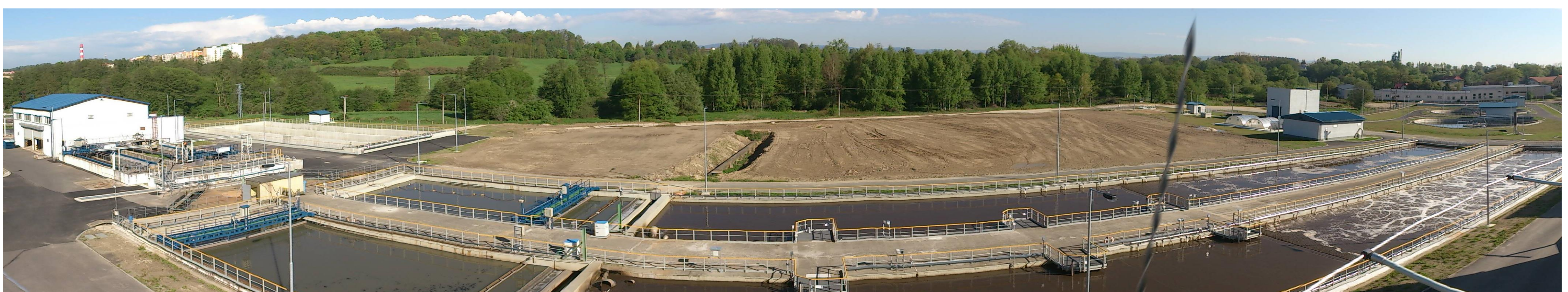
Obrázek 2: čistírna odpadních vod v Chebu, ČR (Zdroj: CHEVAK Cheb, a.s.)
