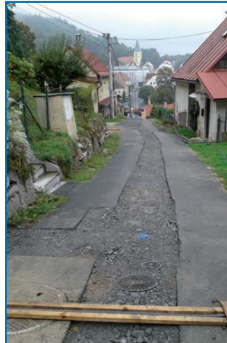
Zásypy rýhy po pokládce potrubí ulice Pod Strání
