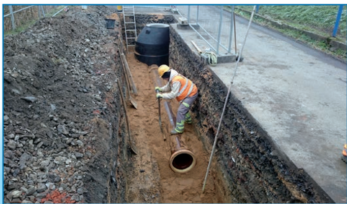
Pokládka kanalizace z kameniny
