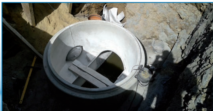
Realizace revizní šachty na stávající stoce
