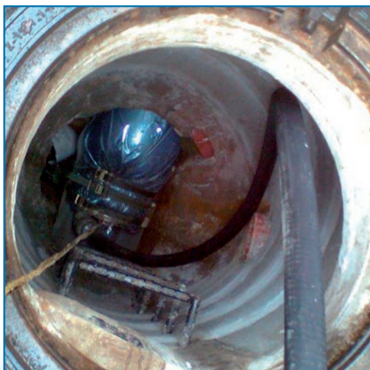
Instalace sklolaminátového rukávu a probíhající vytvrzení UV zářením
