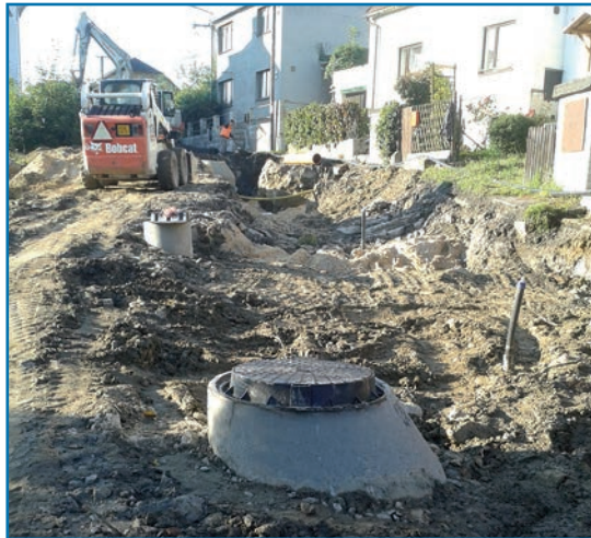
Zásyp kanalizace a vodovodu
