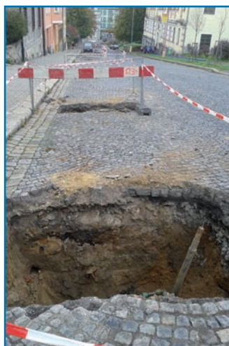
Výkop pro montáž přípojky
