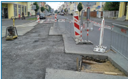
Úpravy povrchů po zatažení potrubí
