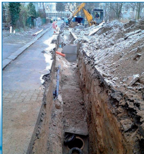
Pokládka vodovodu a kanalizace v jedné rýze
