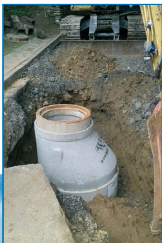
Výkop a pokládka kanalizace
