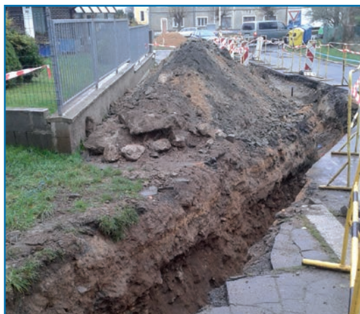
Výkop a pokládka kanalizace
