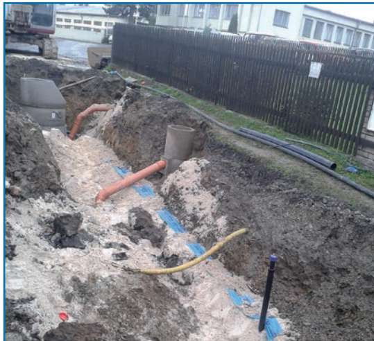
Zásyp kanalizace a vodovodu pískem
