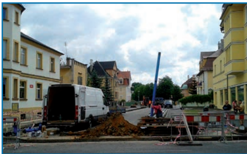
Výkop strojní jámy a propojování potrubí
