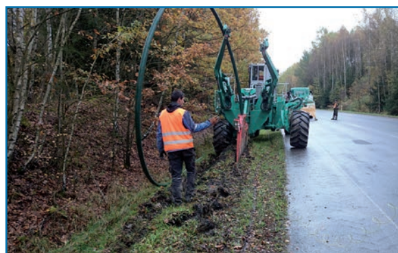
Pokládka kanalizace pluhováním
