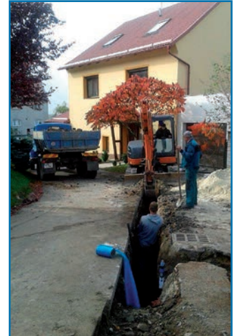
Výkopové práce pro pokládku potrubí ulice Malé náměstí
